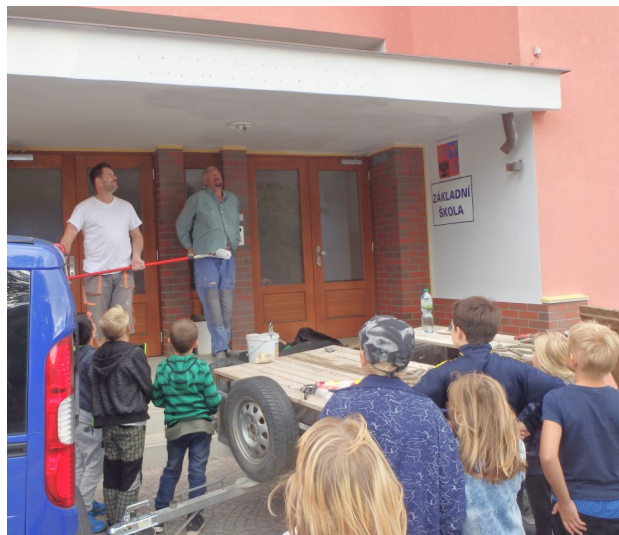
Opravuje se nám na škole průčelí.
