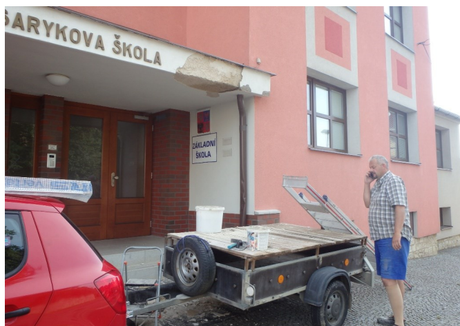
Opravují nám průčelí školy
